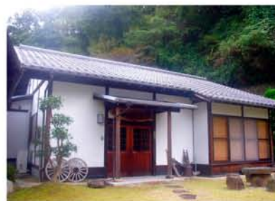
「レミニセンス夢亭」…回想療法の拠点です竹の天井や囲炉裏があり、昔懐かしい民家を再現しています。
