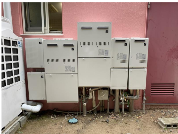
ガス給湯器取替
