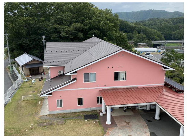
屋根・外壁補修
