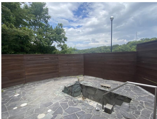
露天風呂檜目隠し板塀改修
