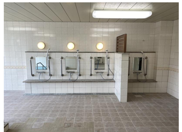
浴室洗い場・シャワー水栓改修
