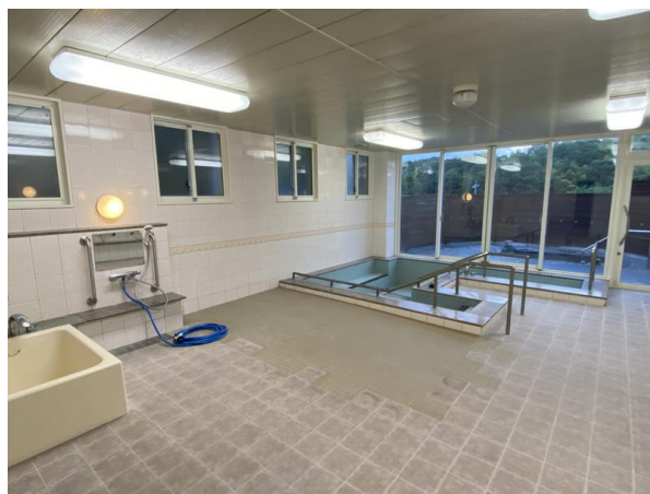
浴室檜風呂撤去・タイル張替
