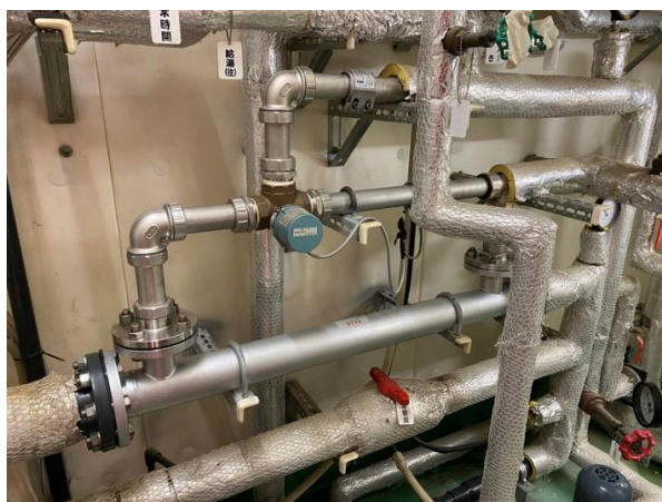
浴室浴槽循環器機改修
